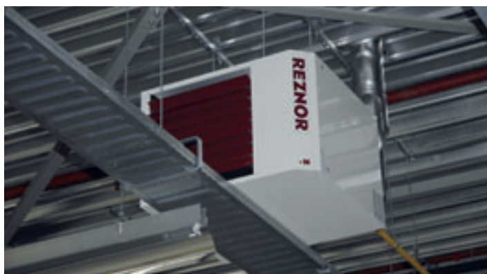
2. Een luchtverwarmer in het opslaggedeelte.
