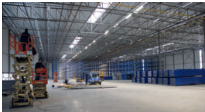
1. Het opslaggedeelte van het nieuwe magazijn van Plieger in aanbouw.
